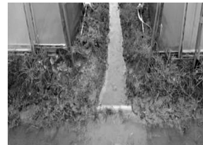
育苗ハウスのまわりに排水溝を掘り、置床を乾燥させる。
