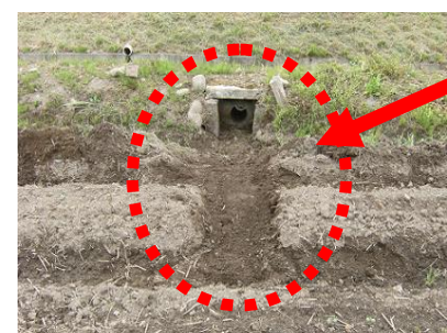
図2 排水溝の連結
