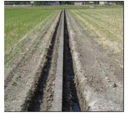
額縁排水溝の設置
